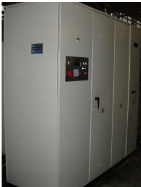
Рис. 3. Тиристорный преобразователь частоты ТПЧП-1800-0,25 с цифровой системой управления
