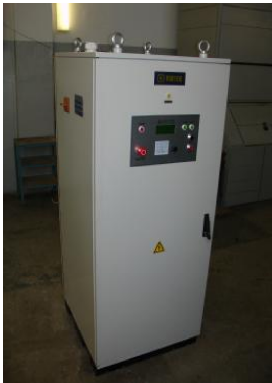
Рис. 5. Тиристорный преобразователь частоты ТПЧР-320-10 с цифровой системой управления
